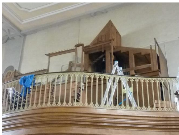
Démontage de l'orgue Mai 2017
