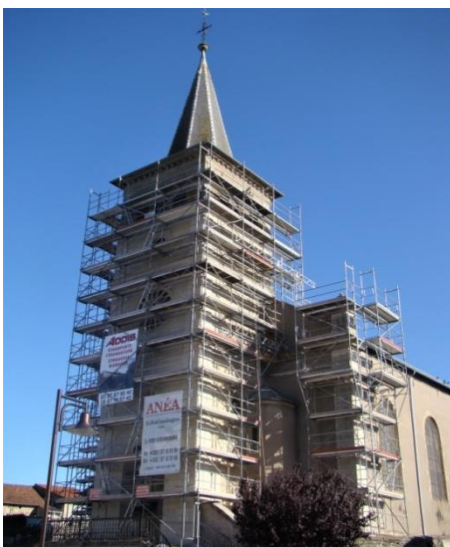
Mise en place de l'échafaudage Septembre 2011
