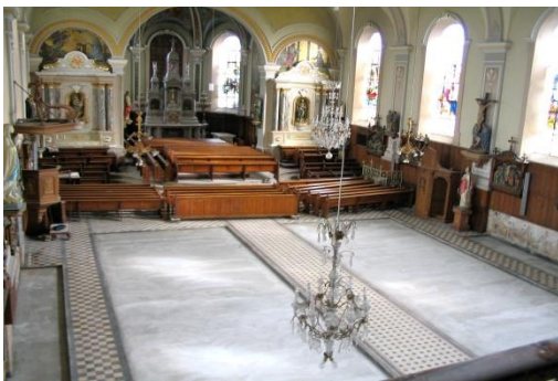
Coulage béton 5° phase 30.01.2007
