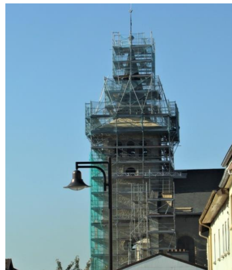
Rénovation du toit du clocher réalisée Par l'entreprise ADDIS de Spicheren Octobre 2011
