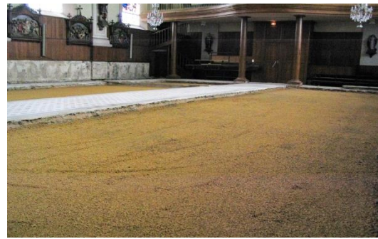
Pose géotextile et calcaire 4° 25.01.2007
