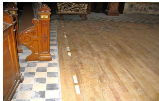
Pose plancher 6° phase 23.03.2007
